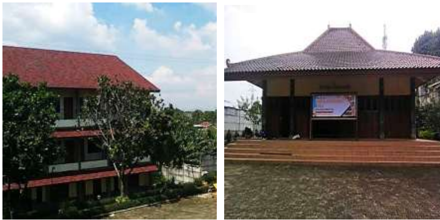
Gambar 2. Kondisi Eksisting Lokasi Penelitian.
