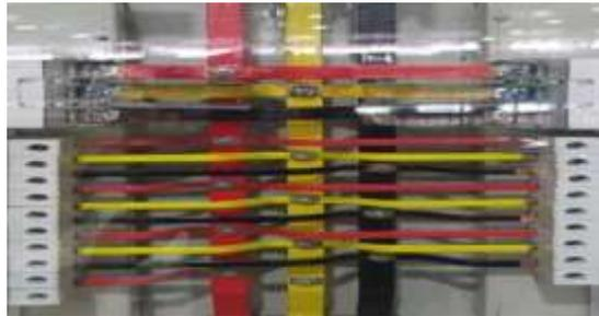
**Gambar. Contoh Busbar pada Panel Listrik**
