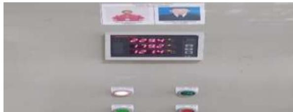
**Gambar. Power Meter pada panel MDP**
