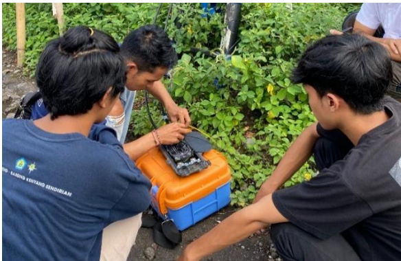
Gambar 2. Proses Penyambungan kabel FO
