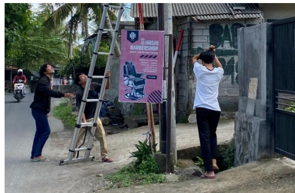
Gambar 3. Proses Penarikan Kabel FO
