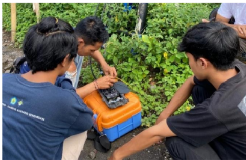
Gambar 2. Proses Penyambungan kabel FO
