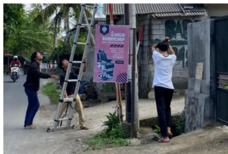
Gambar 3. Proses Penarikan Kabel FO
